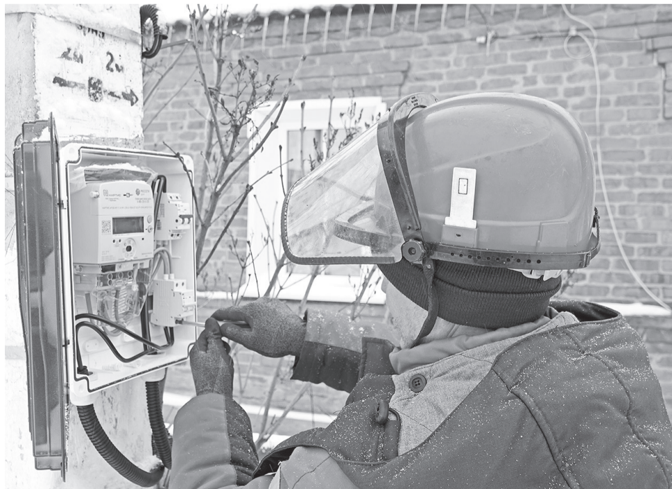
Монтаж «умного» счётчика
