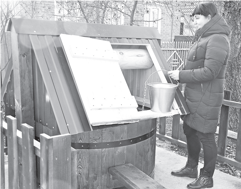
Отремонтированный колодец в Белянском сельском поселении
