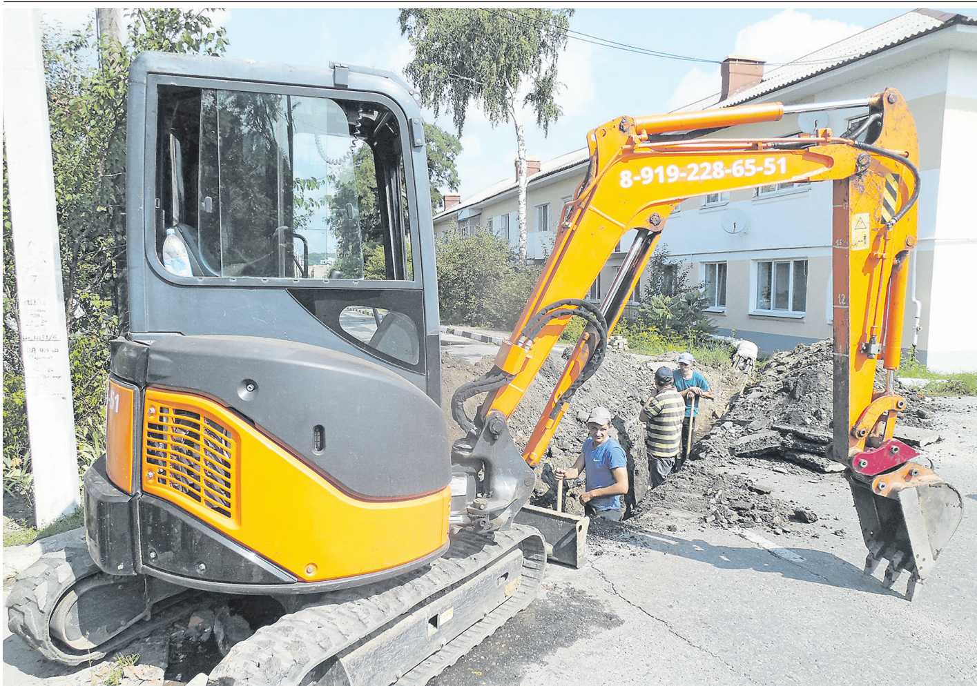
Ремонтные работы выполняют сотрудники АО «Борисовская теплосетевая компания»
