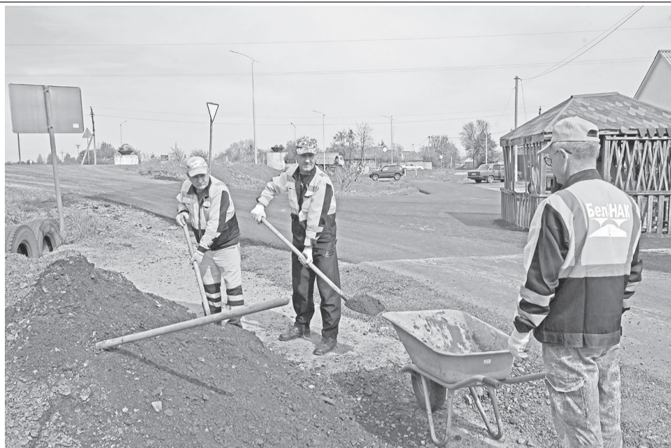
Дорожные работы на улице Колхозной в селе Зозули
