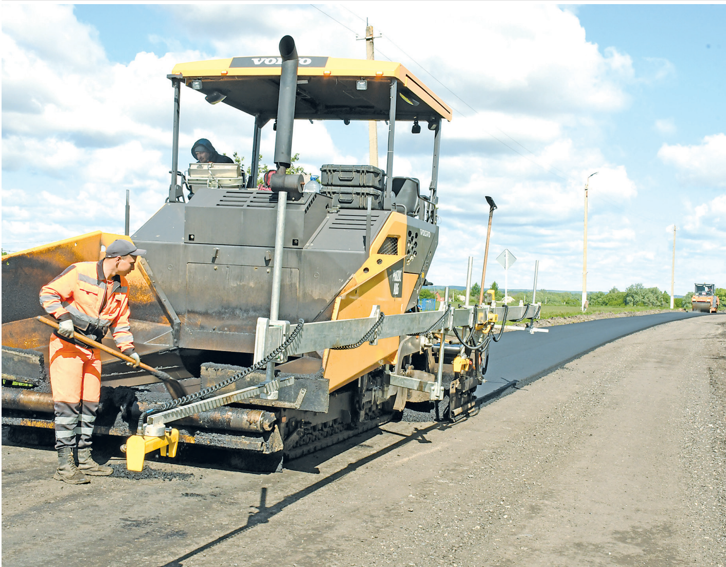
Ремонтные работы на участке «Крым-Комсомольский-Красиво» проводит ГК «БЕЛЗНАК»
