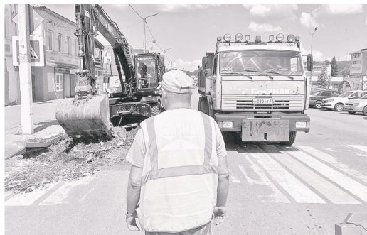
Дорожные работы в посёлке Борисовка
