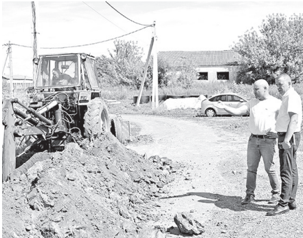
Строительство водопровода в посёлке Борисовка
