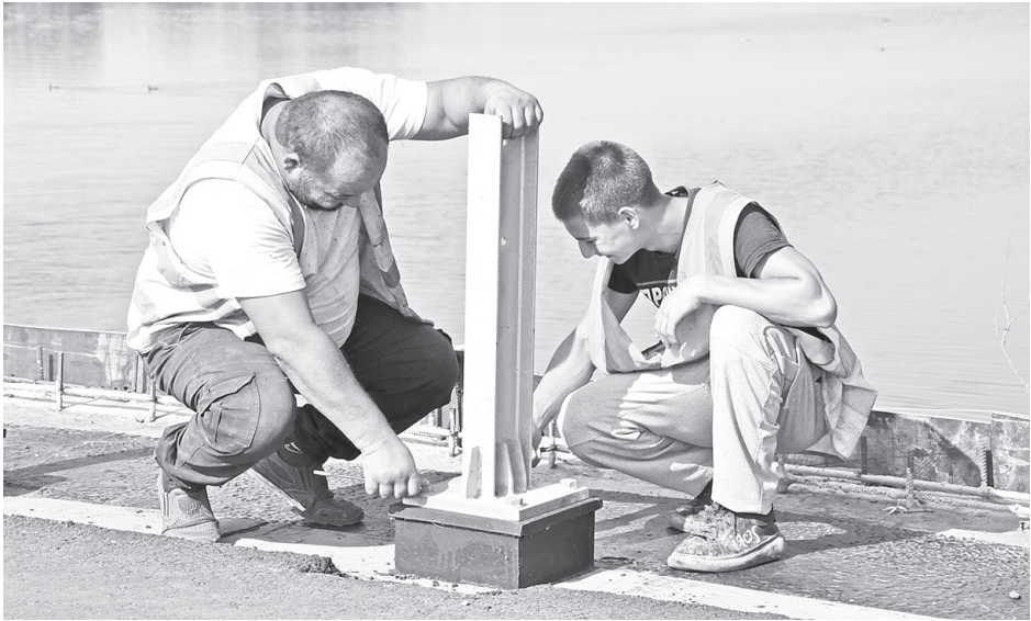
Установкой стоек ограждения занимаются ремонтники ООО «Стройсервис» Иван и Ренат Ковяченко
