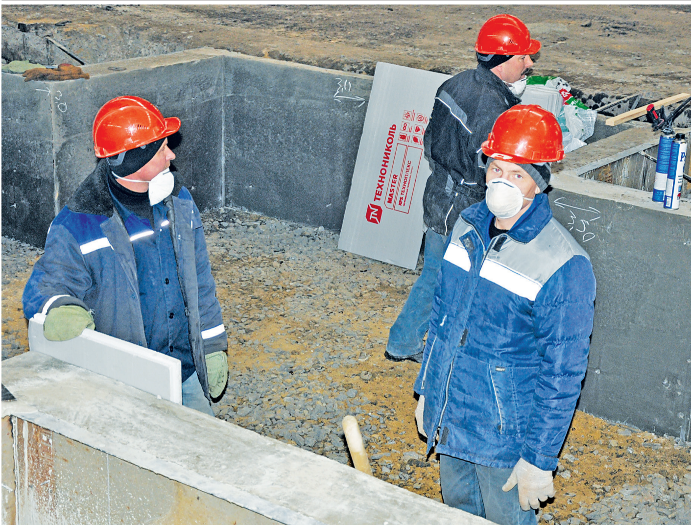
Подготовка фундамента под новый станок на БЗММК им. В.А. Скляренко
