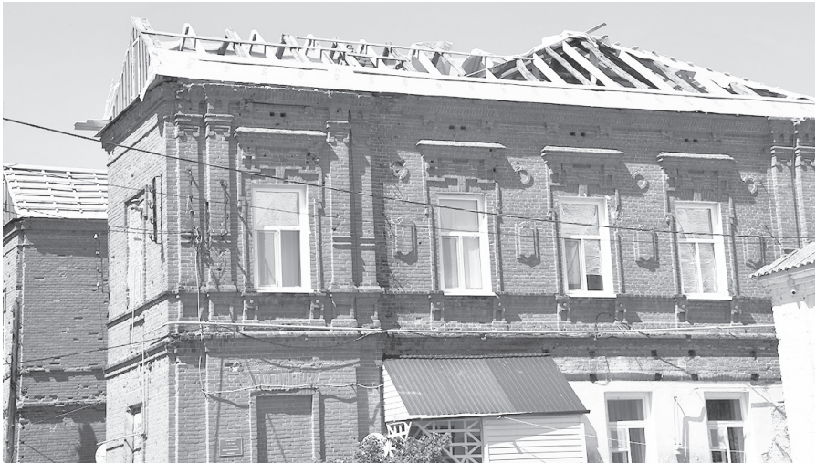
Ремонт кровли жилого дома по улице Первомайская
