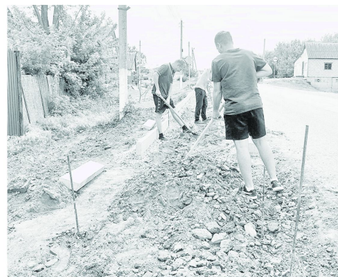
Работы в селе Стригуны
