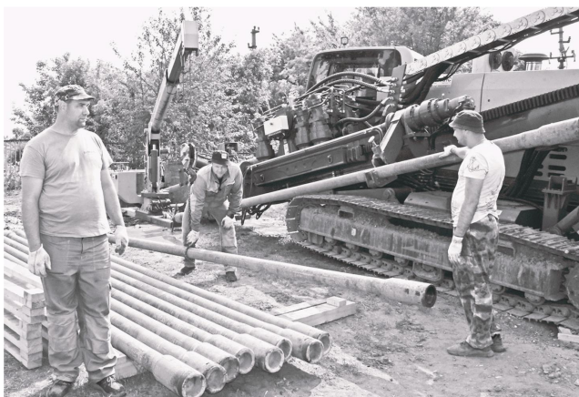
Работы на участке горизонтального бурения
