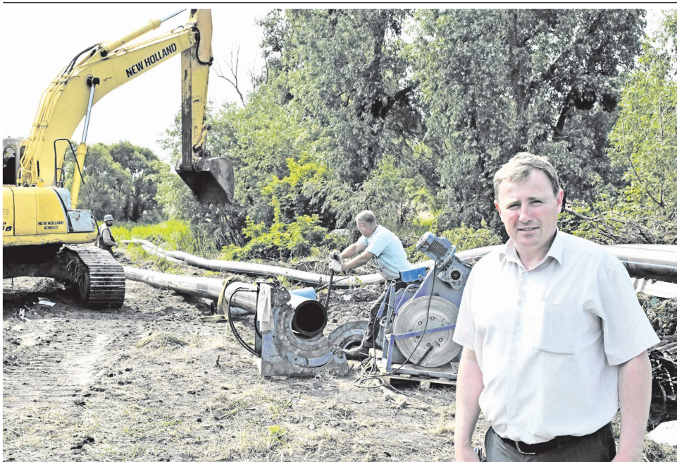
Директор производственного подразделения Андрей Мироненко на участке спайки труб коллектора
