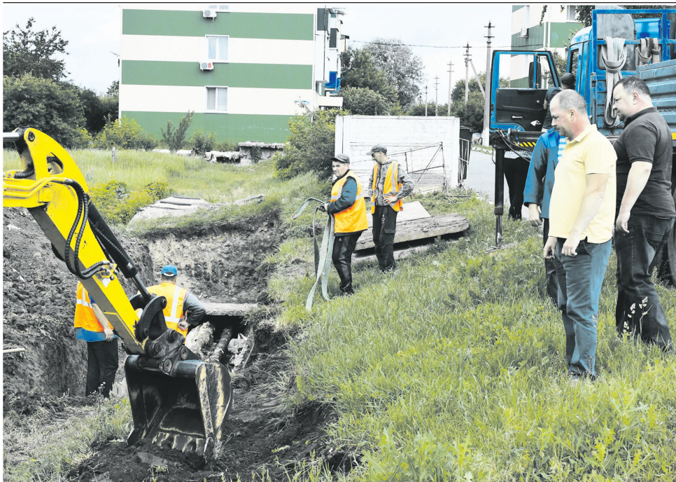
Ремонтные работы на участке по улице Советской
