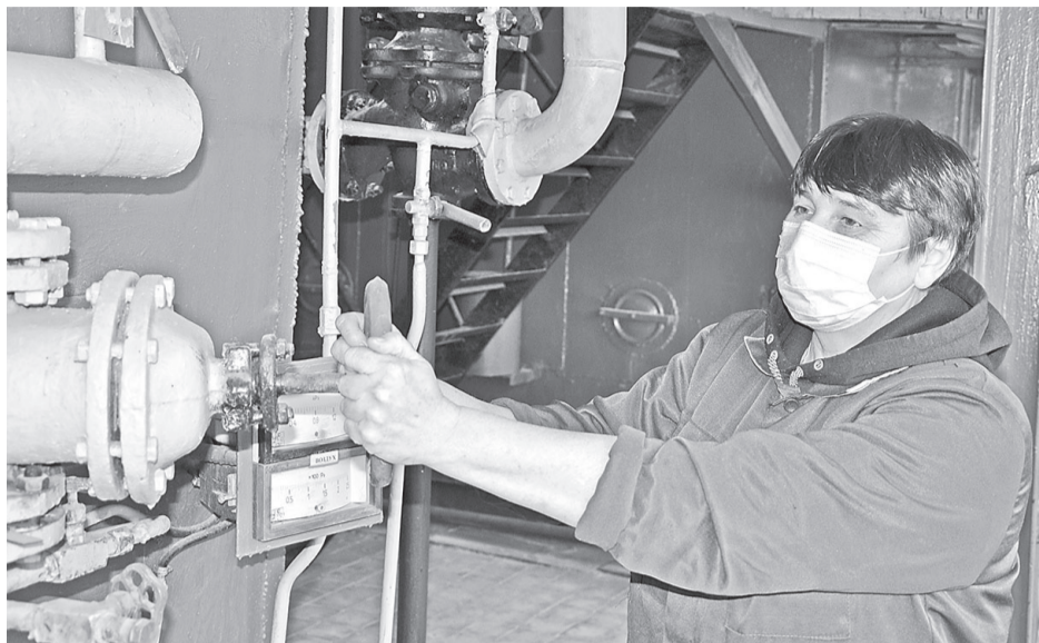
Оператор котельной №1 Людмила Задворная производит розжиг котла
